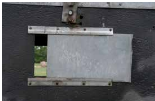
Ventilationsåbningen justeres løbende, så der er et godt klima i hytten. Foto: Heidi M. Andersen
