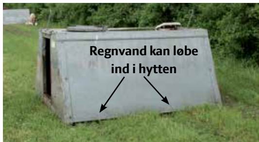
Forkert placering, terrænet er ujævnt, og vand kan løbe ind i hytten. Foto: Heidi M. Andersen
